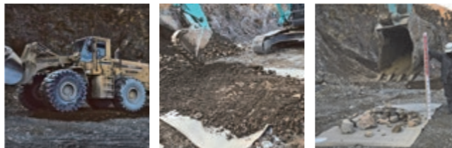
重機走行、バックホー掻き出し、碎石落下試験
